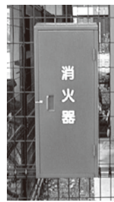
屋外用消火器
