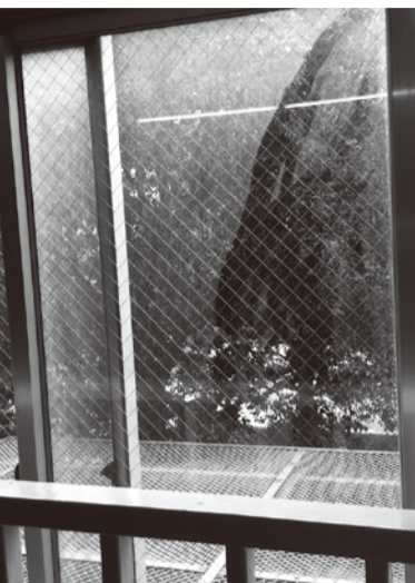
◎エレベータホールの窓の外側が汚れています。清掃をしてください。(5号棟)
