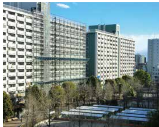
3号棟中庭側 (12月26日撮影)
