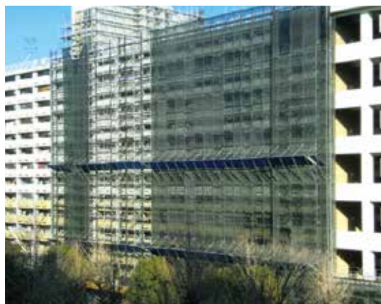
6号棟中庭側 (12月26日撮影)
